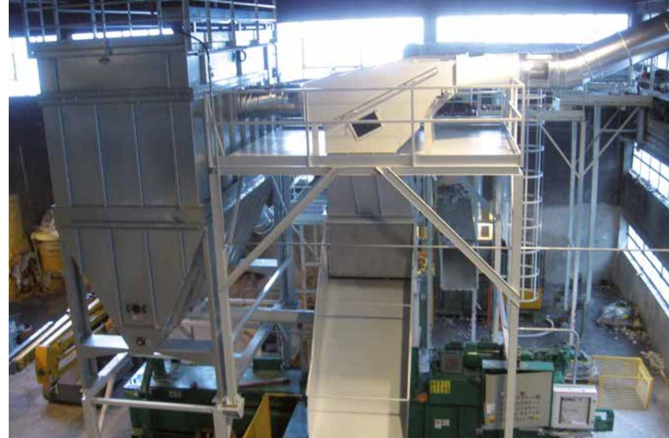
**Stazione di scarico rifiuti in pressa e filtrazione polveri**
