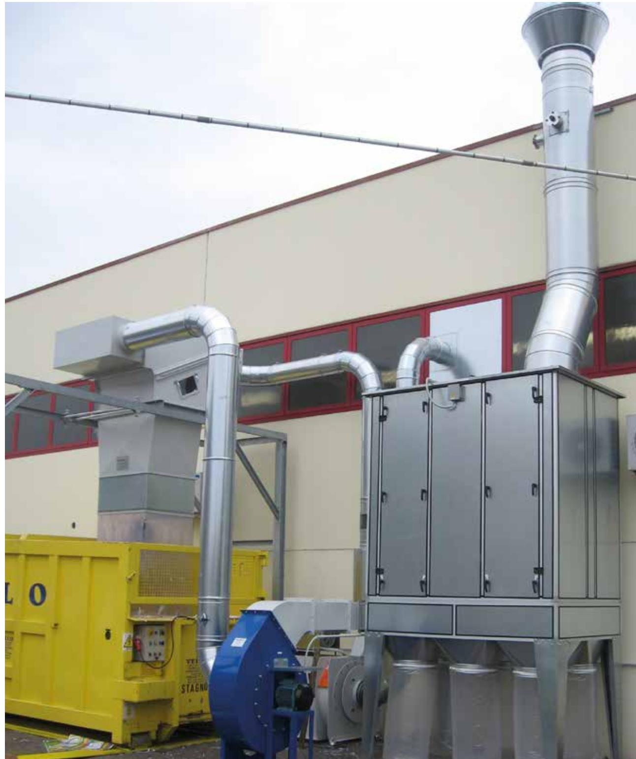
**Separazione rifiuti e filtrazione polveri** - Waste paper separation and dust filtration - Trennung von Produktionsrückständen und Filterung von Stäuben
